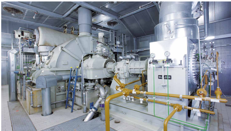
Dampfturbine, Braunkohlekraftwerk
