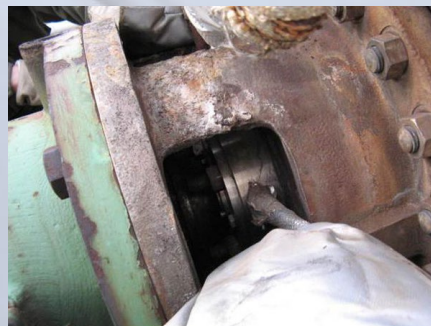
Die Schwefeltransferpumpe nach Umbau auf EagleBurgmann SulfurAce: keine Leckage, keine Kontamination
